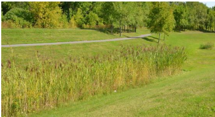
Bassin de rétention
