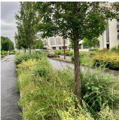
Noues végétalisées et plantées
