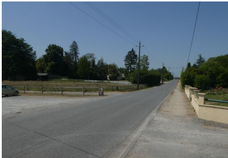
Vue de la D252 et de ses abords qui constituent une légère discontinuité Nord / Sud
